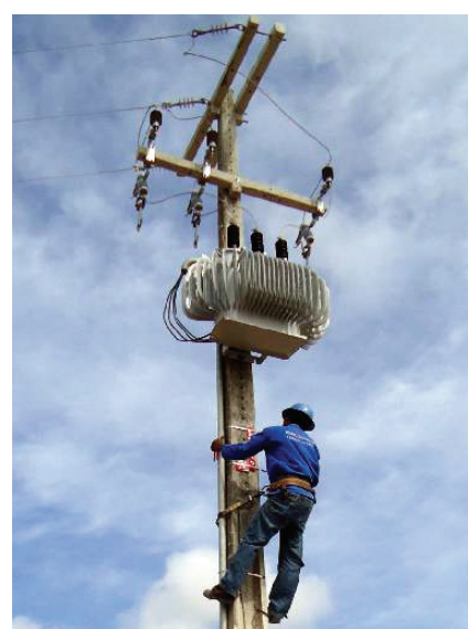
Figura 26: Fotos de um transformador de potência em uma subestação de uma transmissora (A) e de um transformador de rede aérea (B) contendo 120 000 L e 60 L de óleo mineral isolante, respectivamente.
