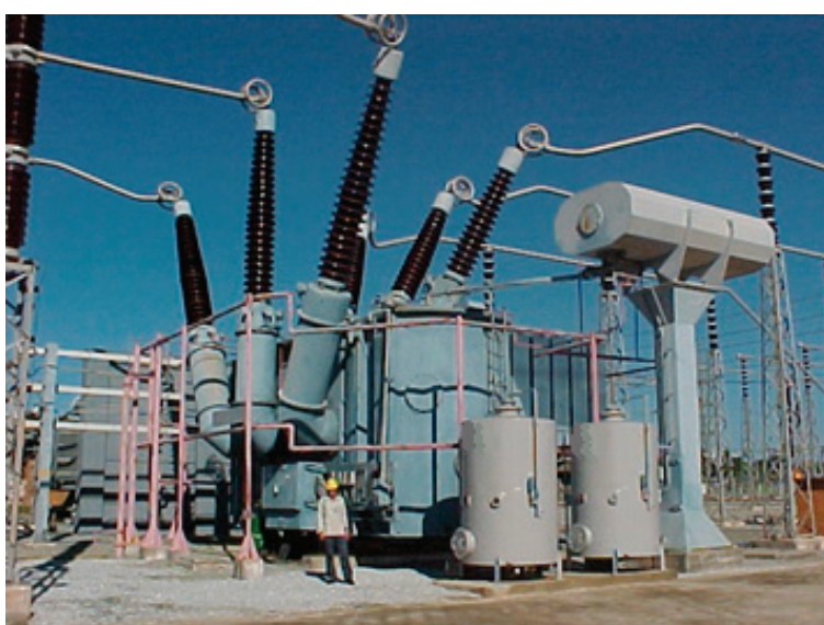
Figura 26: Fotos de um transformador de potência em uma subestação de uma transmissora (A) e de um transformador de rede aérea (B) contendo 120 000 L e 60 L de óleo mineral isolante, respectivamente.
